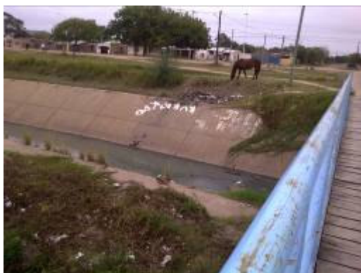
Sector Central del Canal de Av. Soberanía 9 de Julio del 2012
